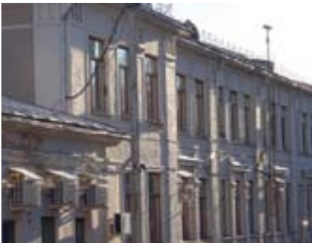
Тыловой фасад (кроме одного ризалита) не оштукатурен, через покраску хорошо просматривается кирпичная кладка.
