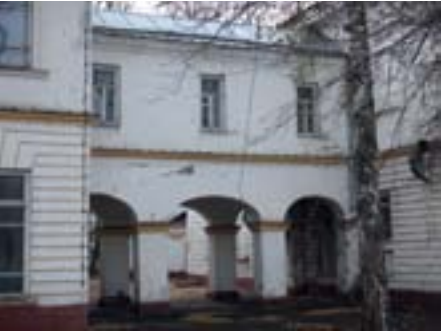
Переходная галерея, соединяющая два корпуса по второму этажу, выполнена на столбах.
